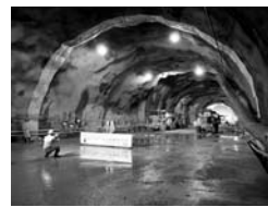
KAGRAトンネル掘削中の様子
