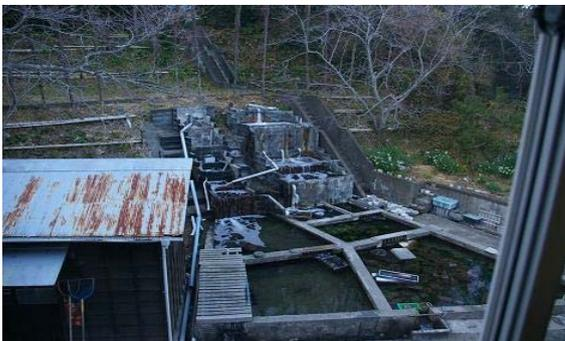
写真3．屋外水槽の一部。海水をいったん実験所脇の山の上のタンクにくみ上げ、そこから屋外水槽に流している。
